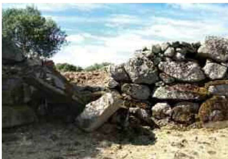
Fig. 4 - Tula. Sa Mandra Manna. Muraglia megalitica: crollo del paramento esterno.
